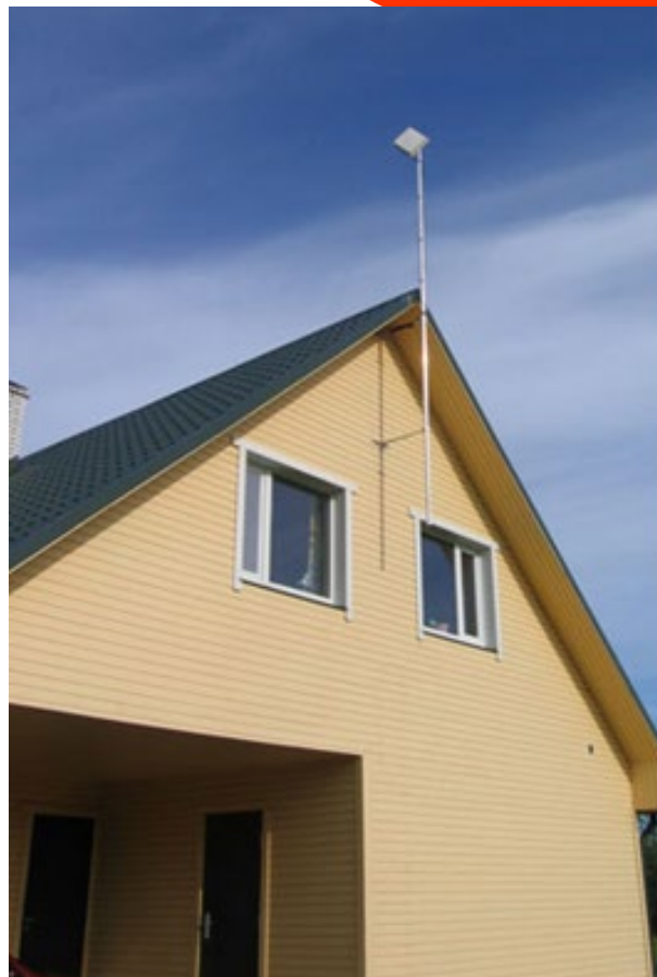
Pilt 1: Tüüpiline kodune paigaldus teleskoop-kronsteinidega maja seinalt üle katuse.
